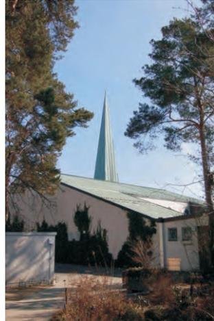
Die Kirche ist ein schlichter Hallenbau (17 x 24 m) mit schmalen seitenschiffartigen Gängen, einem flach geneigten Satteldach und einem seitlich stehenden 30 Meter hohen Glockenturm mit spitzem Zelt Dach. Die Höhe des Kirchenschiffes steigt von 6 m über den Seitengängen auf 8,50 m am Scheitelpunkt des Daches. Die Decke wird von je 7 schlanken Pfeilern getragen, die der Nord- und Süd wand frei vorgestellt
